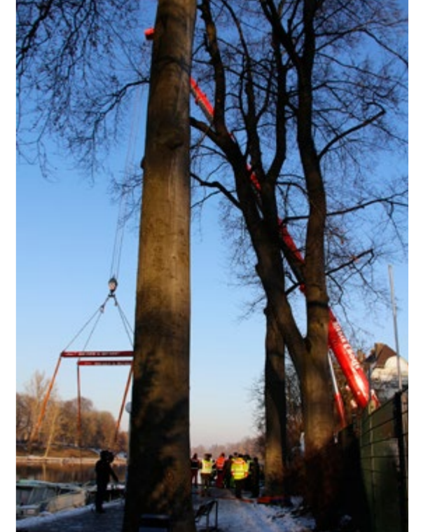
Beengte Platzverhältnisse erschwerten das Aufstellen eines Krans.
