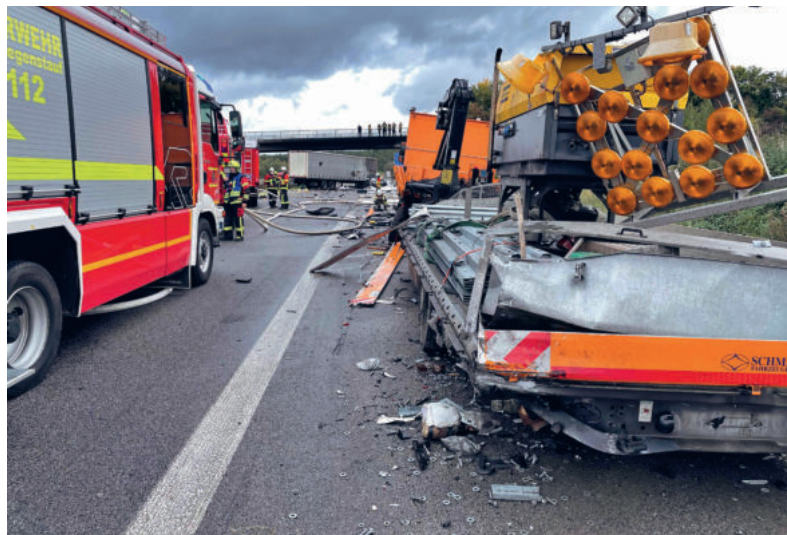
Rechts im Bild: Das gerammte Baustellenfahr- zeug mit VSA
