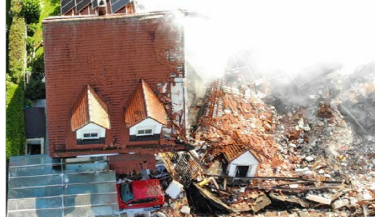
In der Luftaufnahme deutlich zu sehen: Die rechte Doppelhaushälfte ist vollkommen zerstört, das Nachbarhaus stark beschädigt.
