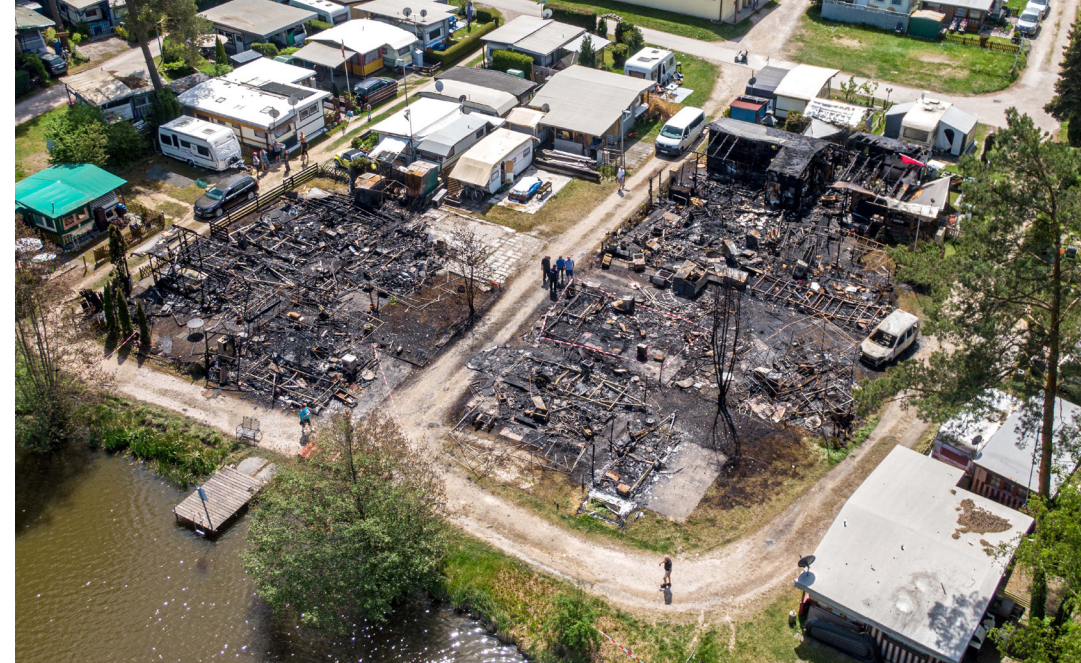
Luftaufnahme am Tag nach dem Brand
