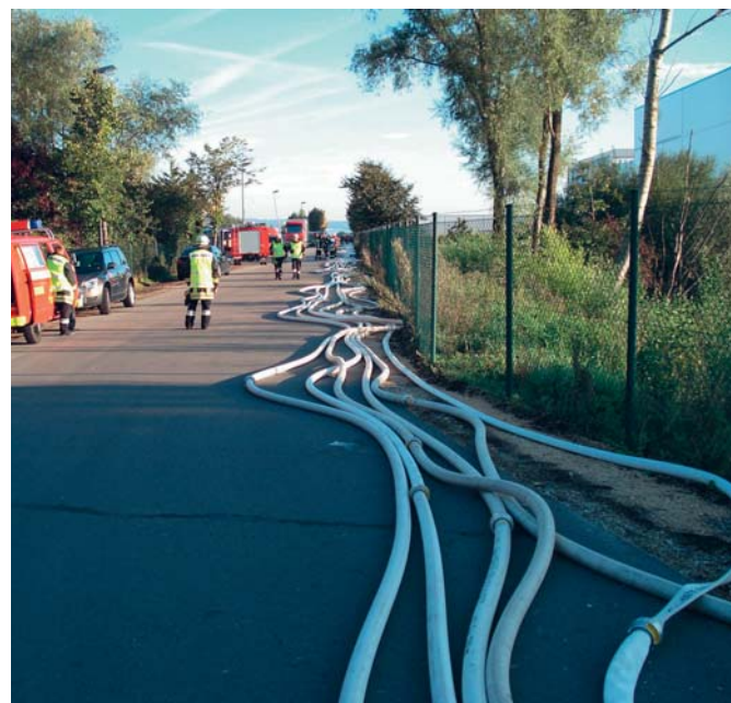
Vorbildlich waren die Schlauchleitungen über lange Strecken verlegt.
