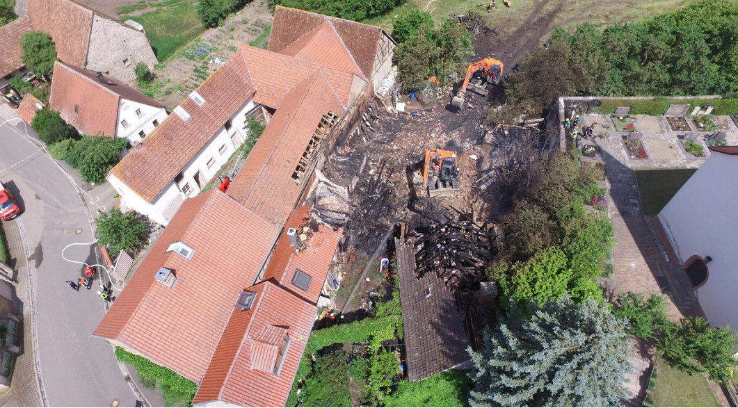
Bei den Abbrucharbeiten; dort wo der Bagger im Vordergrund steht, stand einmal die Scheune; rechts im Bild der angrenzende Friedhof mit der Pfarrkirche
