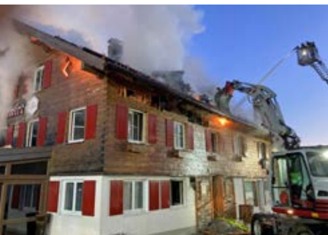
Öffnen des Dachstuhls mit einem Bagger, um mit der Immenstädter Drehleiter eine gezielte Brandbekämpfung zu machen
