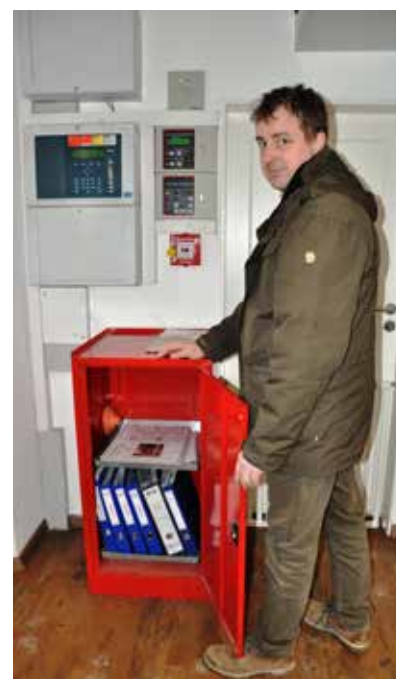
Bild o.: Rauchmelder im Betriebsraum der Delphinlagune Bild u.: Thomas Schiller vor der Zentralen Brandmeldeanlage zeigt die Laufpläne für die Feuerwehr
